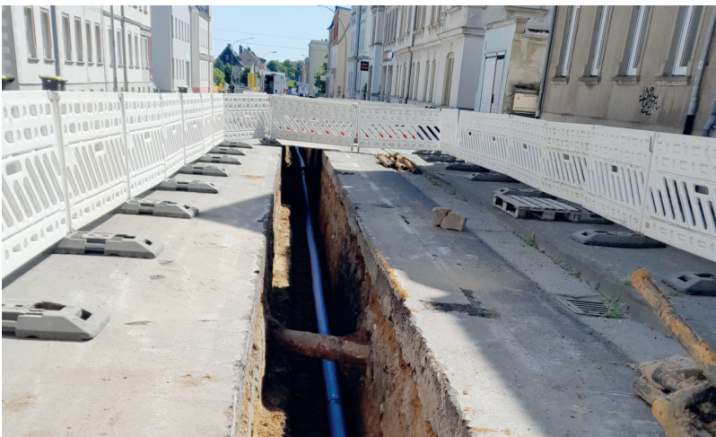
Neuverlegung der Rohrleitungen auf der Lange Straße.
