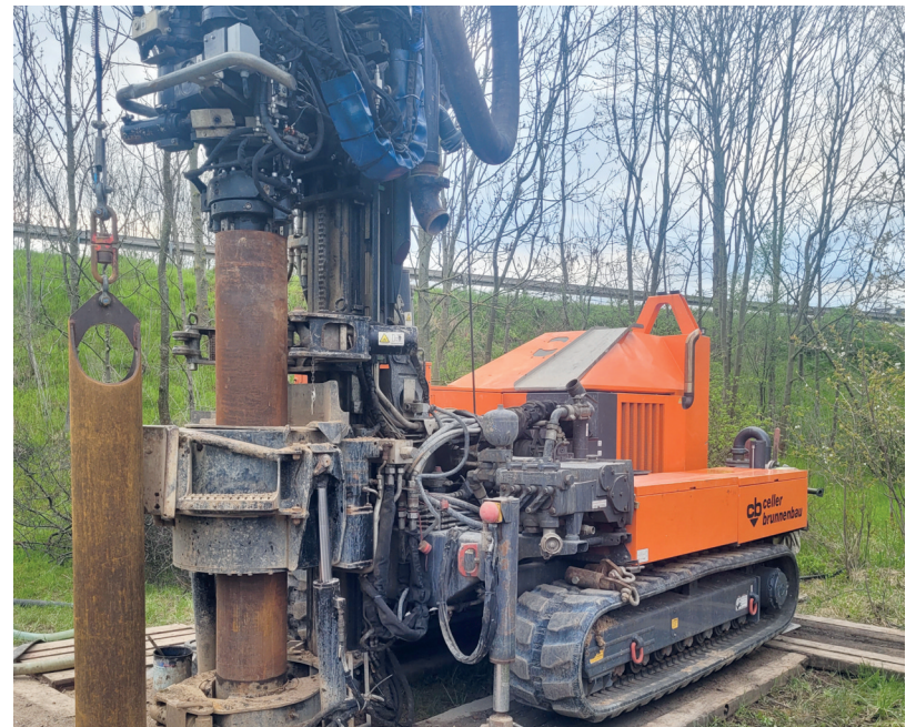
Mit diesem Bohrgerät wurde eine neue Anodenanlage installiert.
