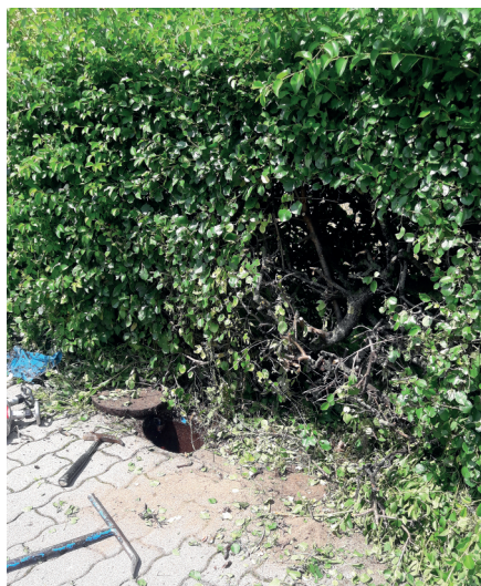
Eine Hecke im Schutzstreifen einer Trinkwasserleitung.
