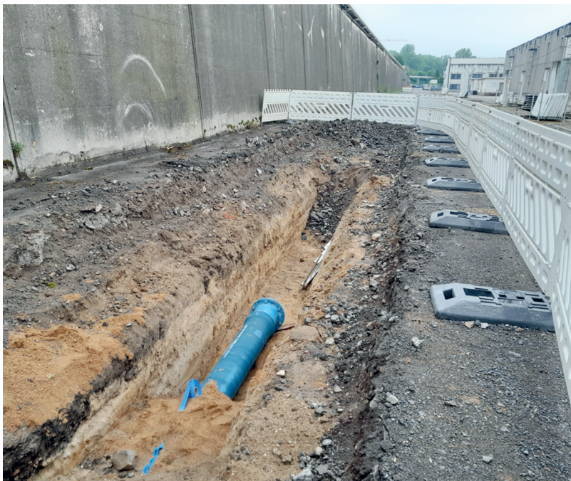
Ein Rohrgraben an der Industriestraße.
