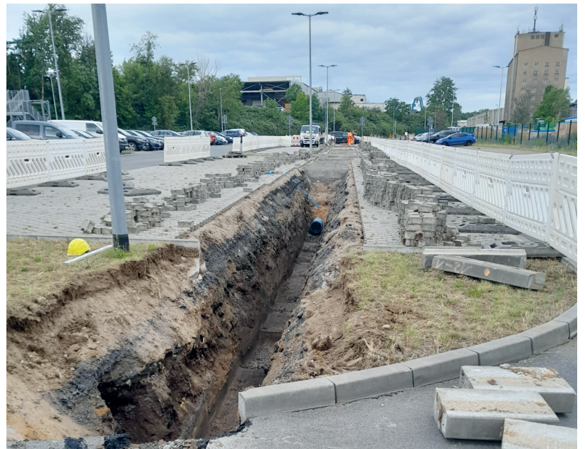
Ein Rohrgraben an der Uttmannstraße.
